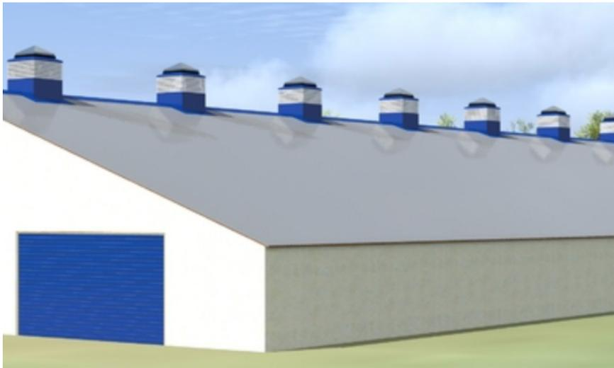
Рис. 2. Установка светоаэратора в коровниках
